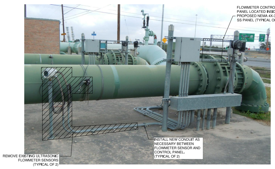
B EXISTING HSP # 4 & 5 FLOWMETER DEMOLITION SCALE: N.T.S.
